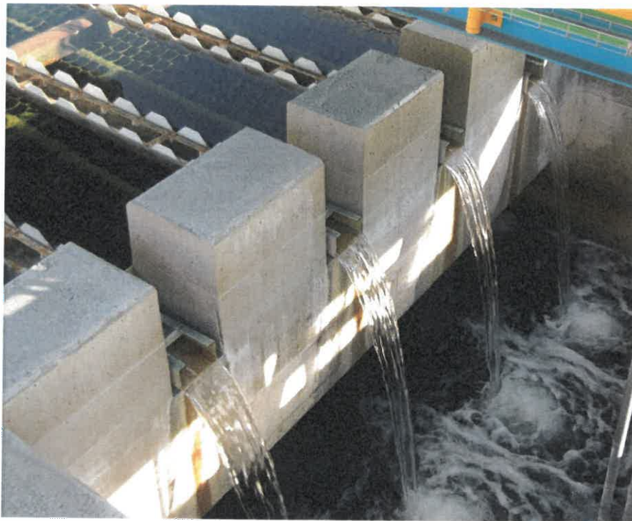
Figura 9. Agua de salida decantador lamelar de la NPTEL
